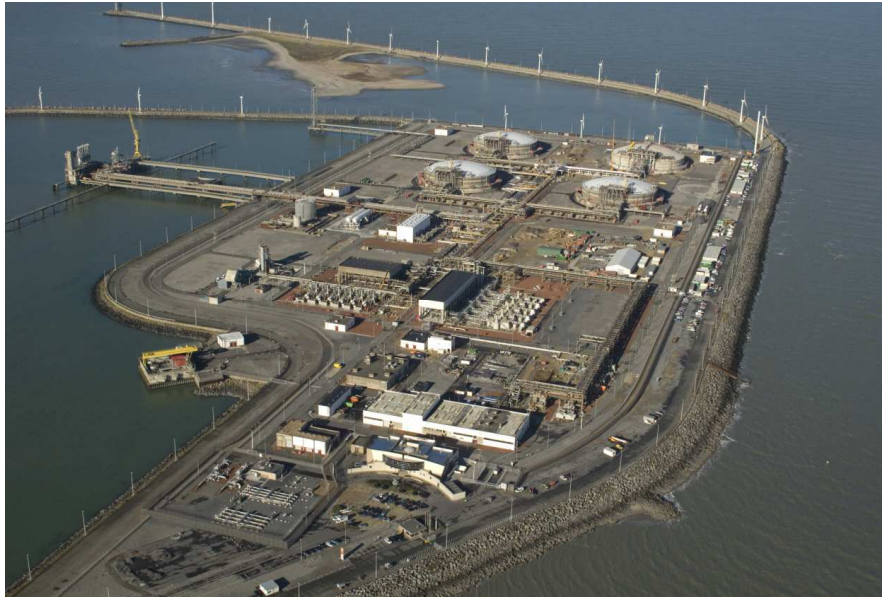
Photo 1 : Terminal de GNL de Zeebruges, 2011
